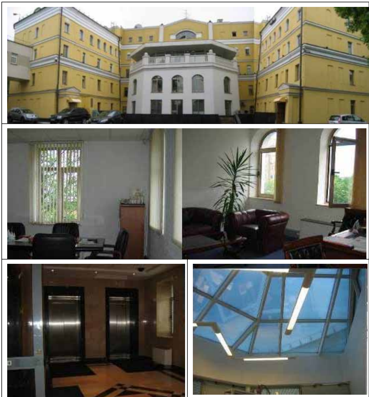
Рис. 15.2 Внешний вид здания ул. Погодинская, д.24, стр.1
