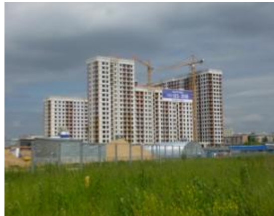
Внешний вид МЖД Корпус 1 на дату оценки
