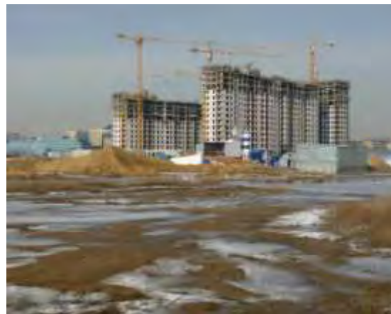
Внешний вид МЖД Корпус 1 на дату оценки
