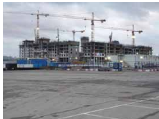
Внешний вид МЖД Корпус 1
